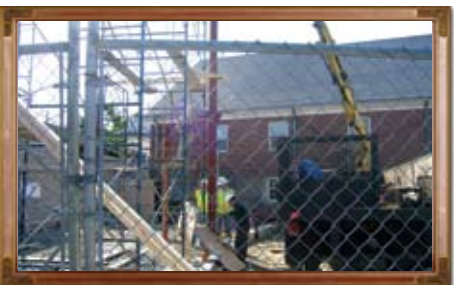
• ECC 공사 전경
